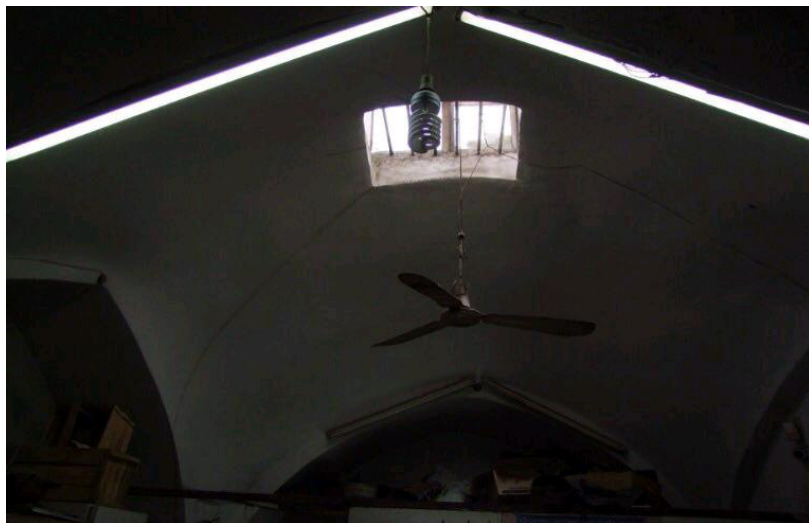
تصویر ۳: سقف گنبدی و هواکش فوقانی حجره نقره‌کاری در بازار مسجد سید اصفهان
